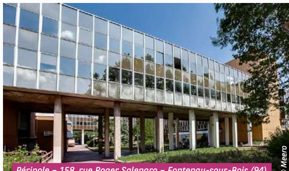
Péripole - 158, rue Roger Salengro - Fontenay-sous-Bois (94) (actif cédé)
